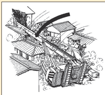
【1991年発生 杭打機 転倒による第三者人身事故】
